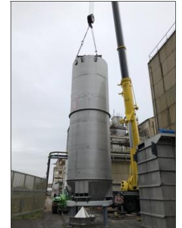
Pose du silo chez Tronox à Thann sur un supportage permettant le montage d'un fond vibrant pour le conditionnement du produit en sacs ou en big-bags. DR Tronox
