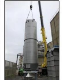
Pose du silo chez Tronox à Thann sur un supportage permettant le montage d'un fond vibrant pour le conditionnement du produit en sacs ou en big-bags. DR Tronox
